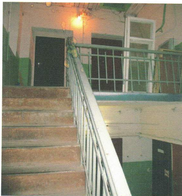
Фото № 24. Северная часть 2-х этажного дома. Междуэтажная лестница с площадкой 3-го этажа. Март 2016 г.
