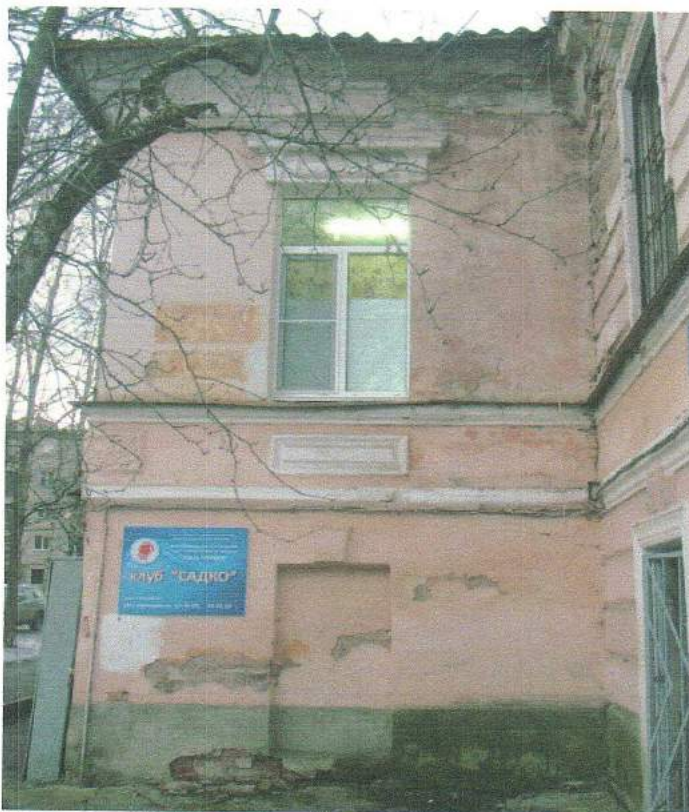
Фото № 11. Восточный фасад (ул. Тимура Фрунзе - Оловянка). Март 2016 г.
