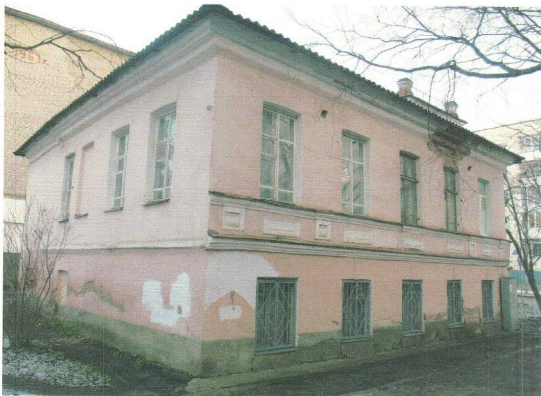
Фото № 2. Общий вид с юго-запада. Март 2016 г.
