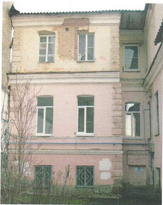
Фото № 9. Западный фасад (дворовой).
