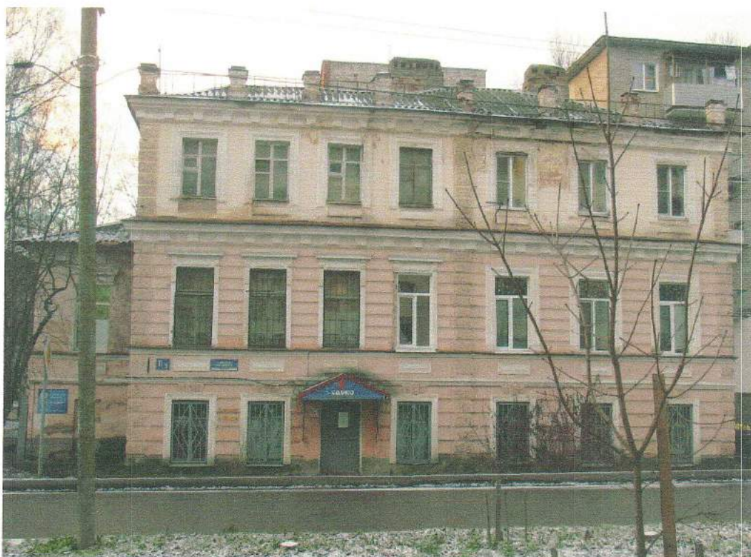
Фото № 4. Восточный фасад (ул. Тимура Фрунзе – Оловянка). Март 2016 г.
