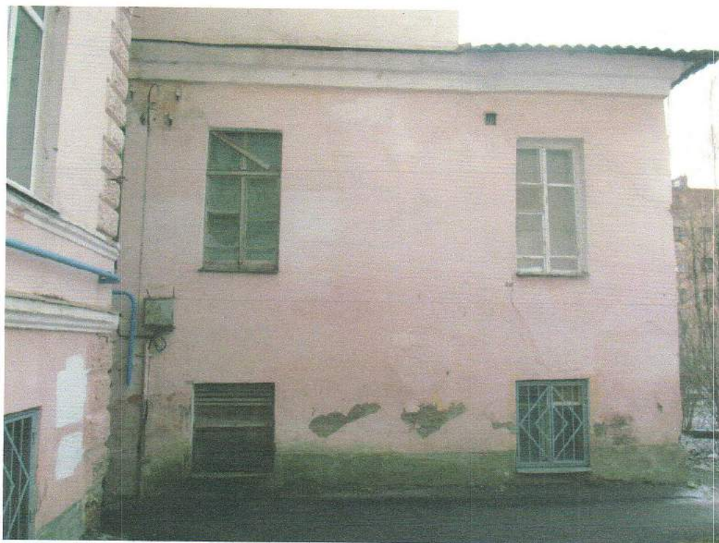
Фото № 7. Северный фасад (дворовой). Март 2016 г.
