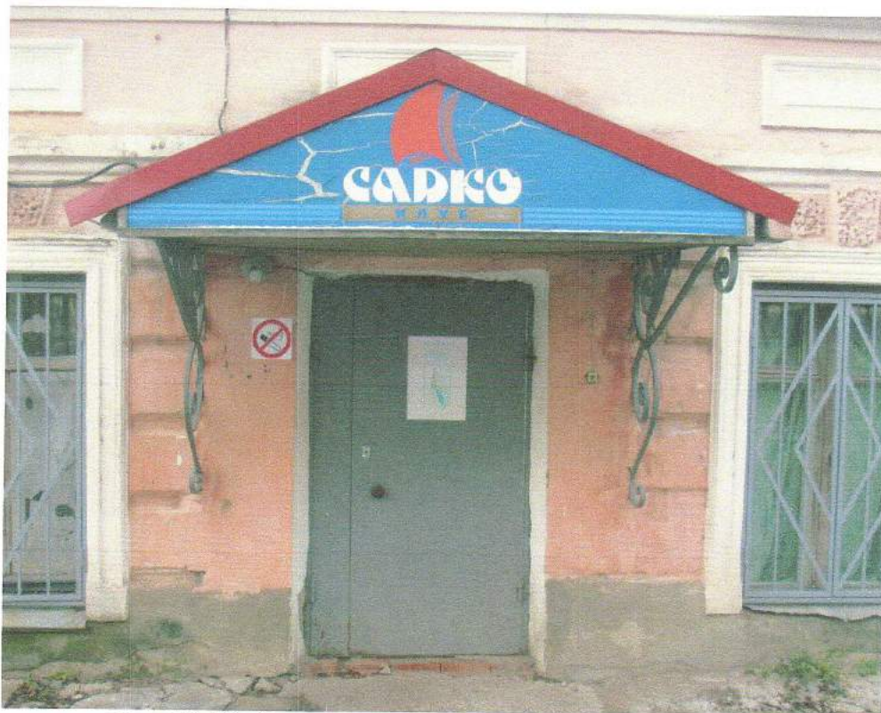
Фото № 12. Фрагмент восточного фасада. Март 2016 г.
