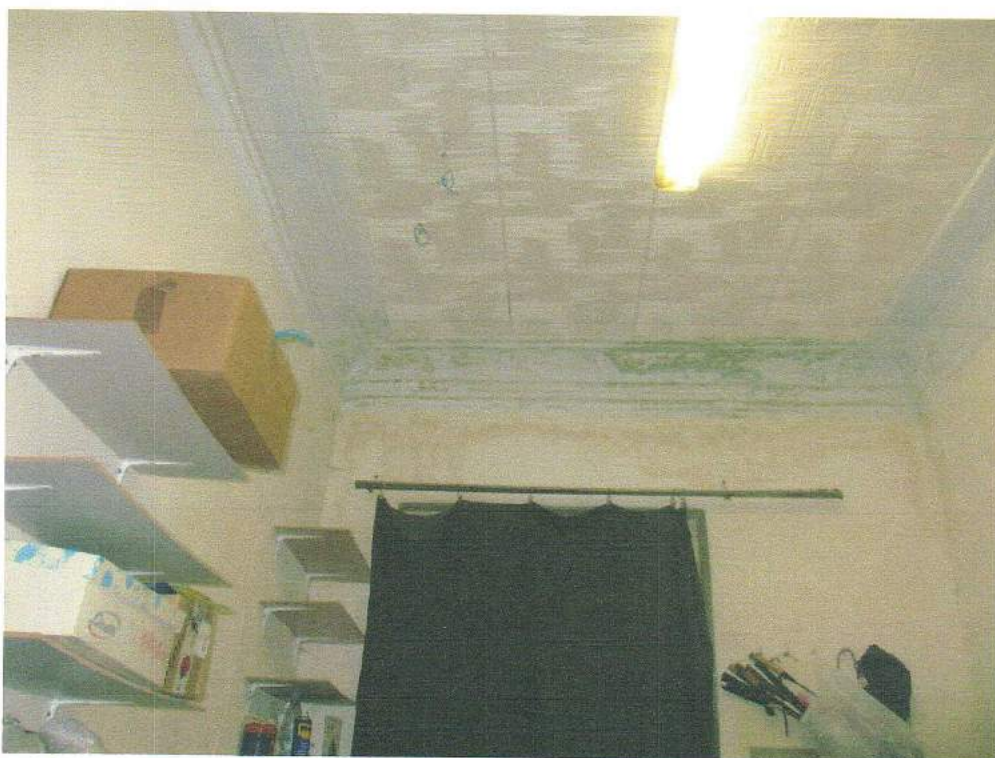
Фото № 27. Южная часть 2-х этажного дома. Интерьер 2-го этажа. Март 2016 г.
