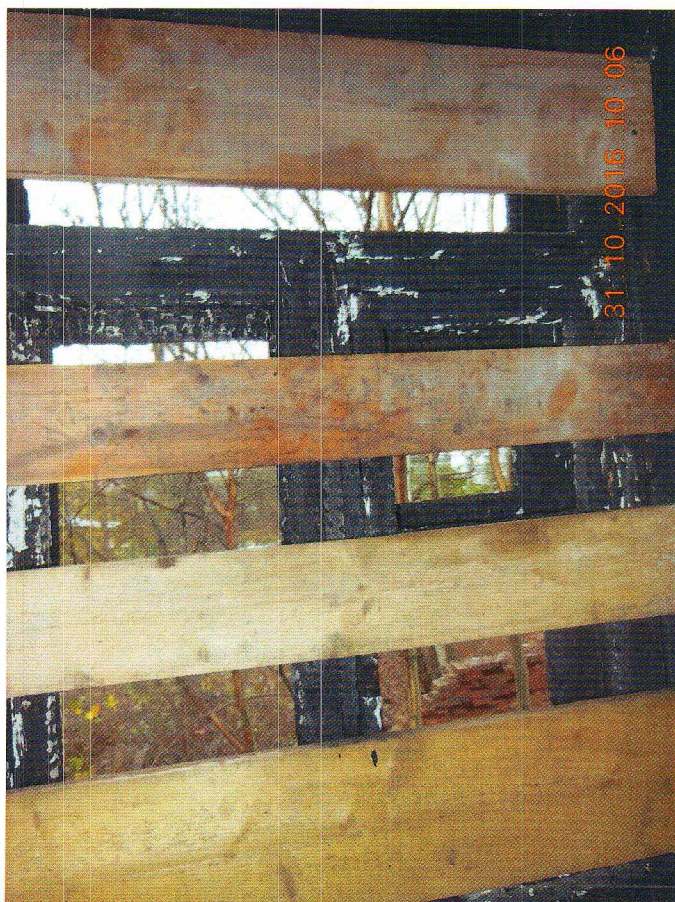
Фото 7. Потолочная поверхность чердачного деревянного перекрытия мезонина (отслоение штукатурного слоя от дранки после пожара).
