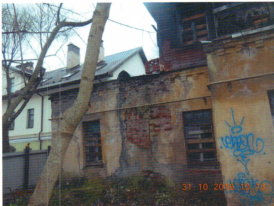
Фото 5. Фрагмент юго – восточного дворового фасада (отслоение штукатурного слоя, деструкция кирпичной кладки, намокание нижних и верхних частей). Вид с юго – востока.
