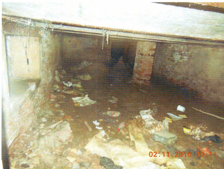
Фото 9. Подвальное помещение на северо – западе.
