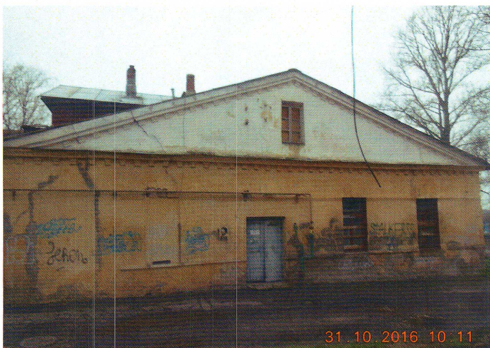
Фото 2. Северо – восточный дворовый фасад. Вид северо – востока.
